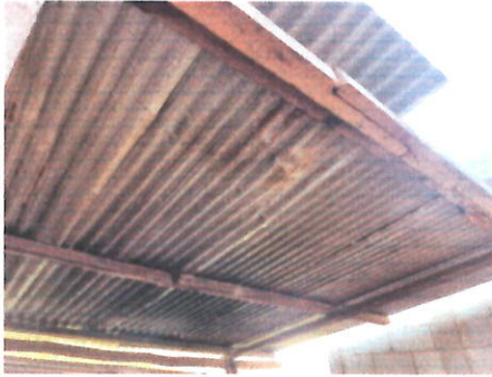
Foto1: Sustitución de cubierta de techo con lámina galvanizada, Tipo de lámina: troquelada Calibre: 26, incluye: fijaciones y sellado en traslapes.
