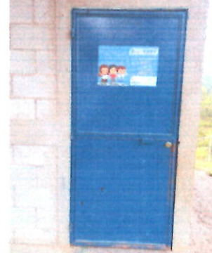
Foto 2: Mantenimiento a puerta metálica existente retiro de óxido, suciedad y pintura deteriorada; incluye cepillado, lijado y aplicación de pintura.
