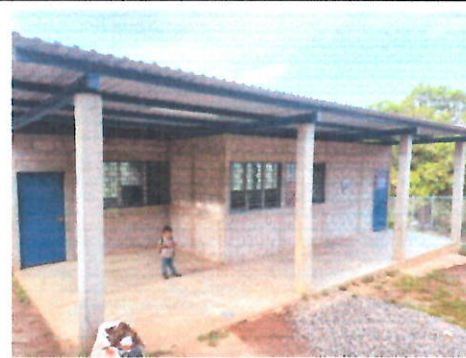
Foto 6: Preparación de la superficie y aplicación de pintura a dos manos, en paredes interiores y exteriores del establecimiento, incluyendo la cocina y sanitarios.
