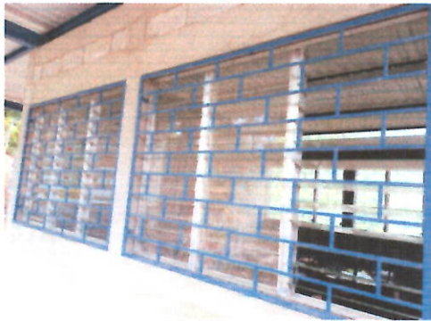
Foto 3: Sustitución de ventanas; sistema de apertura: Corredizas
